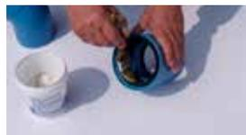
*Enduisez le joint en caoutchouc de lubrifiant*
