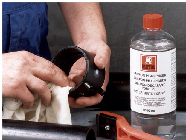
4. Marquez les pièces de conduite et mettez-les dans le manchon à souder. Assurez-vous que les extrémités de tuyau soient sèches.
